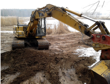
Abb. 2: Mittels Kettenbagger wurde das Aushubmaterial als Flachwasserzone gestaltet Foto: J. Marabini, 16.1.2012
